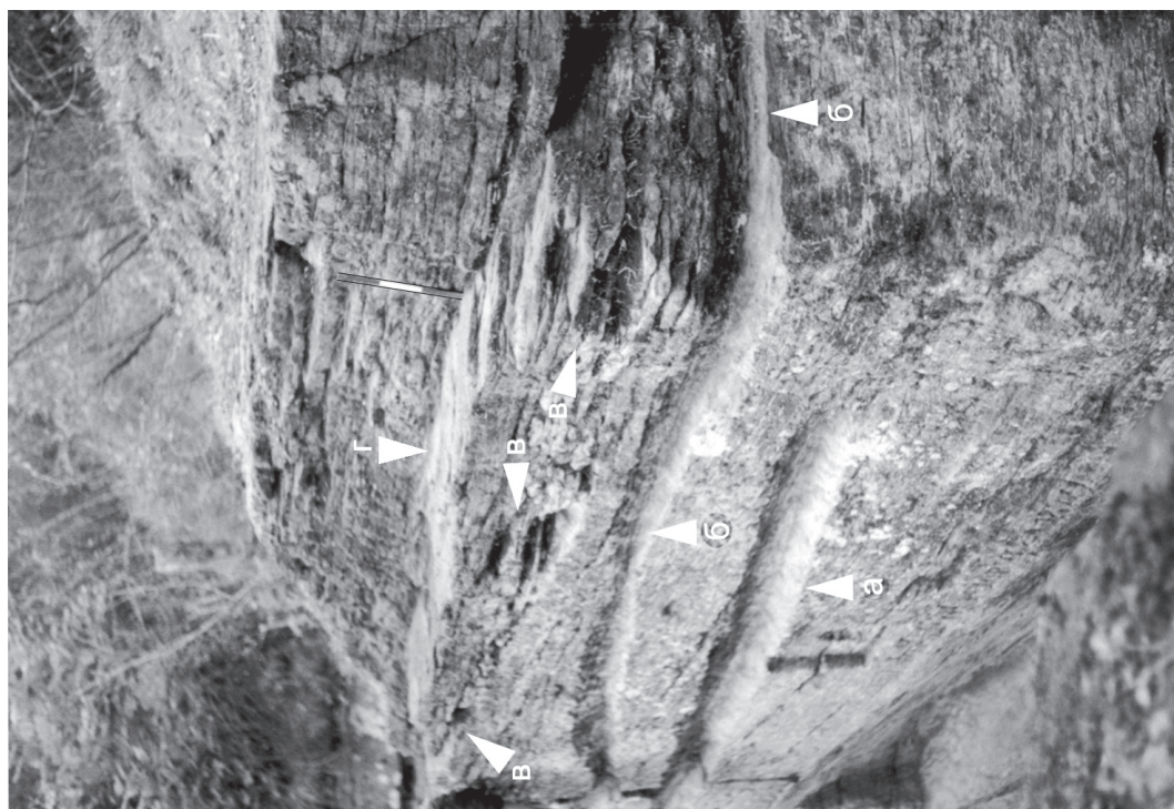
Іл. 3. Західна стінка приміщення № 1 (вигляд з північного боку) з чотирма різнорівневими системами кріплення перекриття: а – нижній жолоб; б – верхній жолоб; в – гнізда; г – вирубка-полиця. Світлина автора 2000 р.
